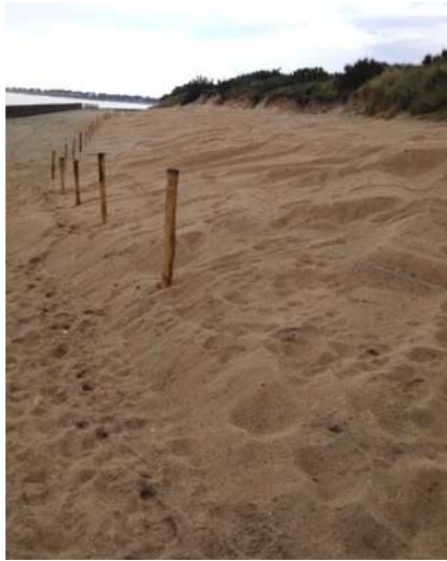
Figure 6.32 : Vue de la zone de dépôt après travaux le 22 juin 2016.
