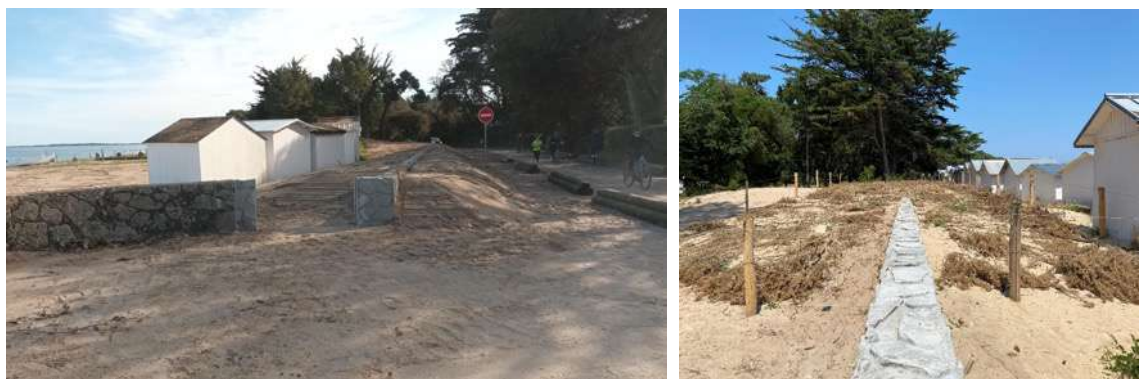
Figure 8.10 : Photos du mur des Sableaux après travaux (2023).
