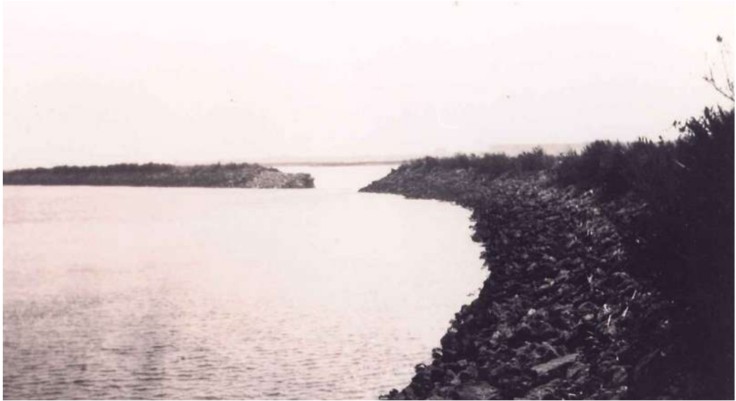
Figure 10.5 : Photographies de mars 1937 : brèche dans la digue du polder de la Grande Rouche (la mer est à gauche de la digue).
