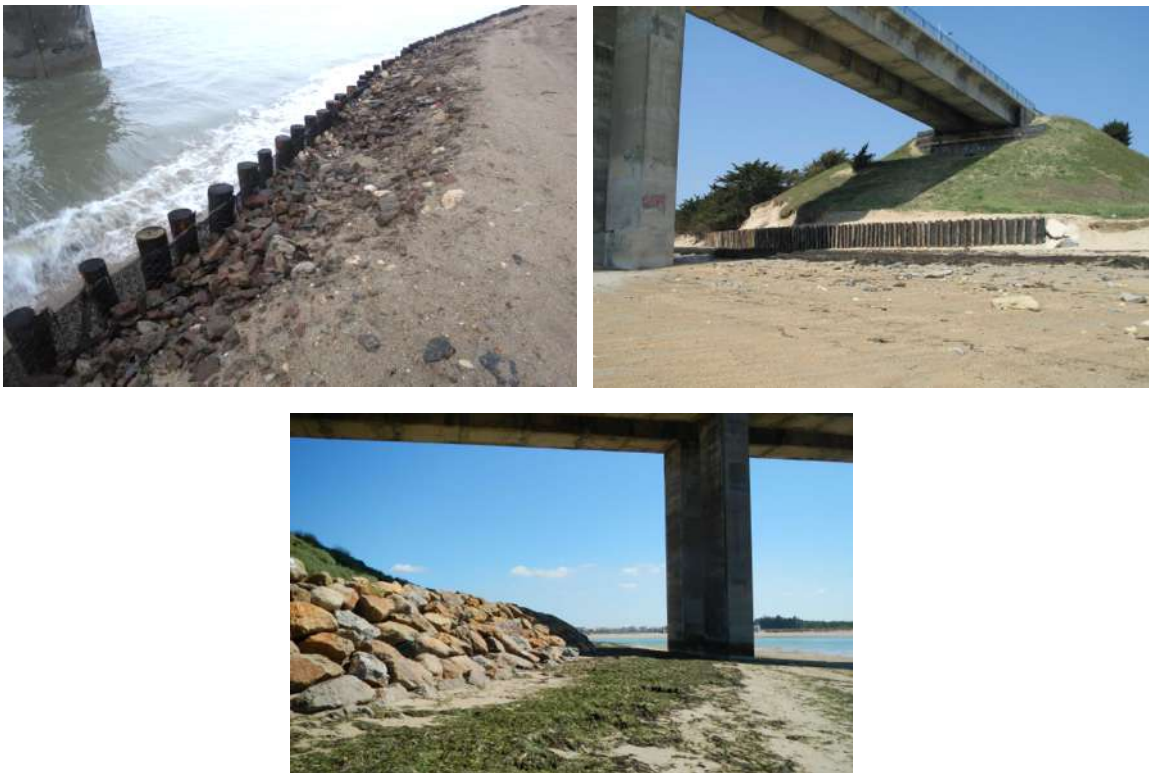
Figure 6.117 : Protections de la culée nord du pont : ouvrage provisoire d'avril-mai 2012, en haut, et ouvrage définitif en 2014, en bas.
