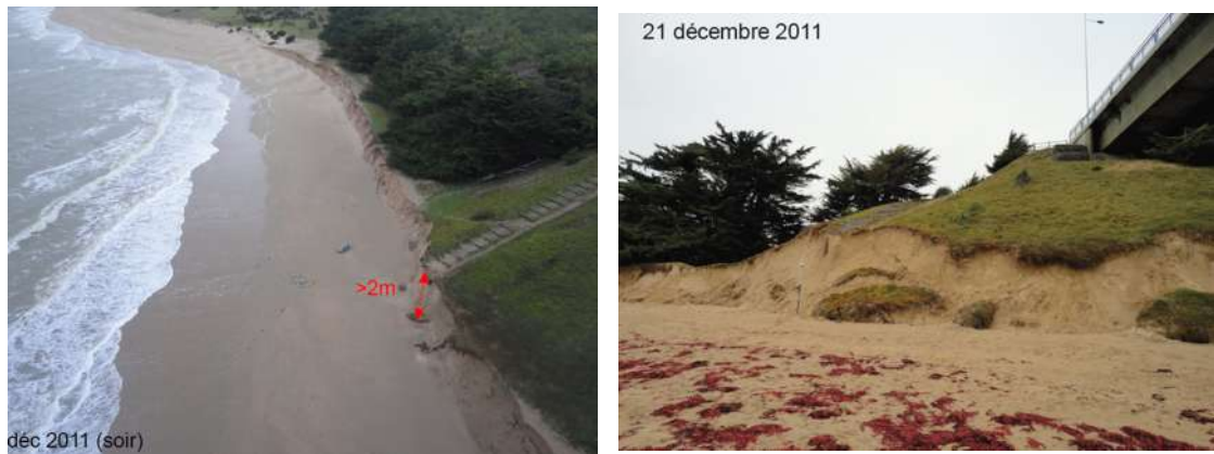
Figure 6.122 : Photographies des faces Est et Sud de la pointe de la Fosse en décembre 2011 : le 14, à gauche, et le 21, à droite (CCIN).
