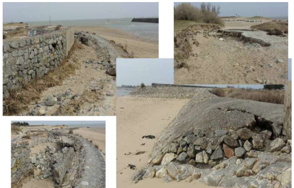
Figure 10.29 : Photographies de la dégradation des ouvrages à l'extrémité Est de la digue de Jacobsen pendant la tempête Xynthia.
