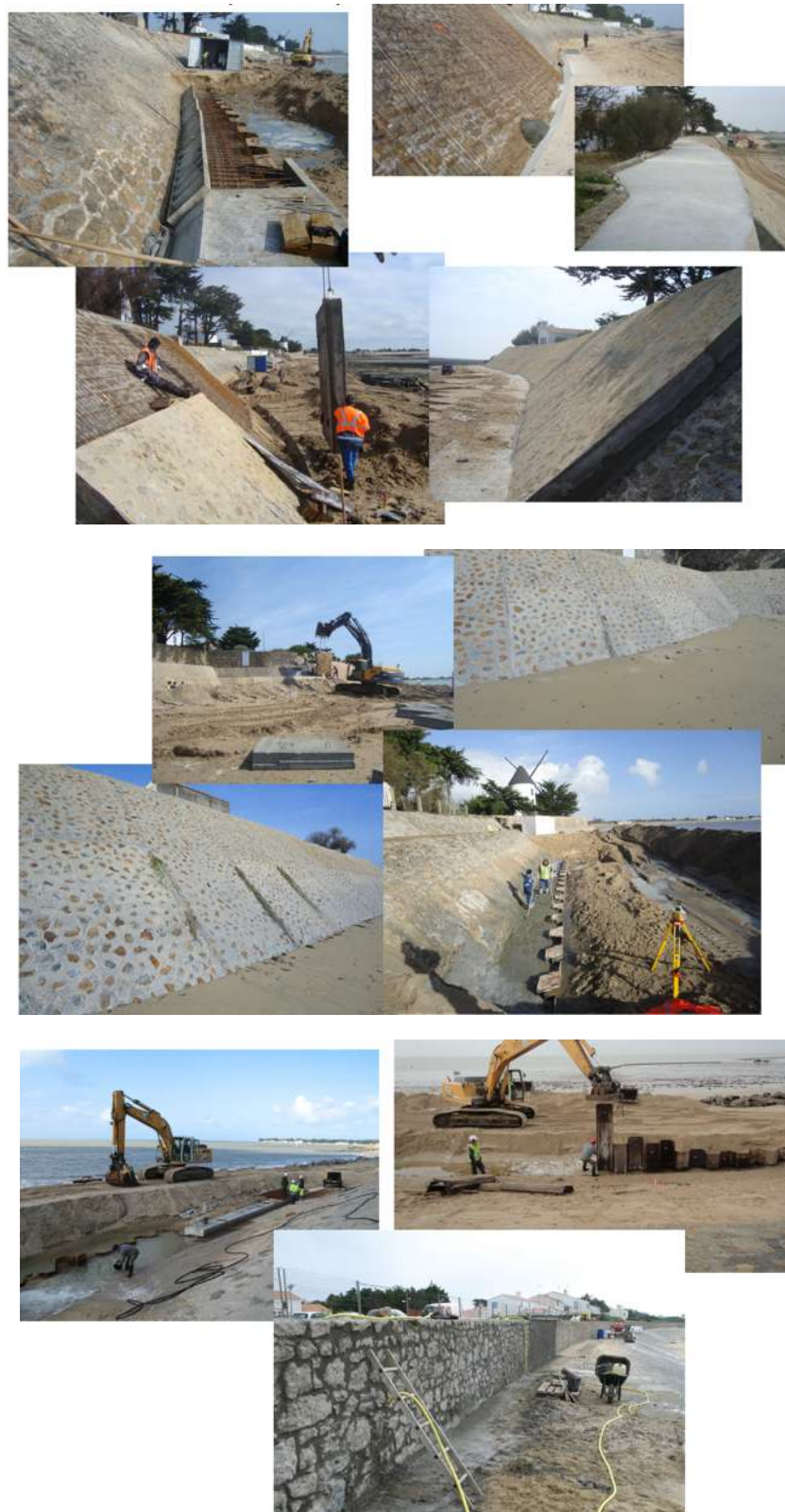
Figure 8.5 : Photos des travaux de consolidation du perré du Fier en 2009 et 2010/2011, en haut et au milieu et du perré de la Rampe en 2013, en bas (CCIN).
