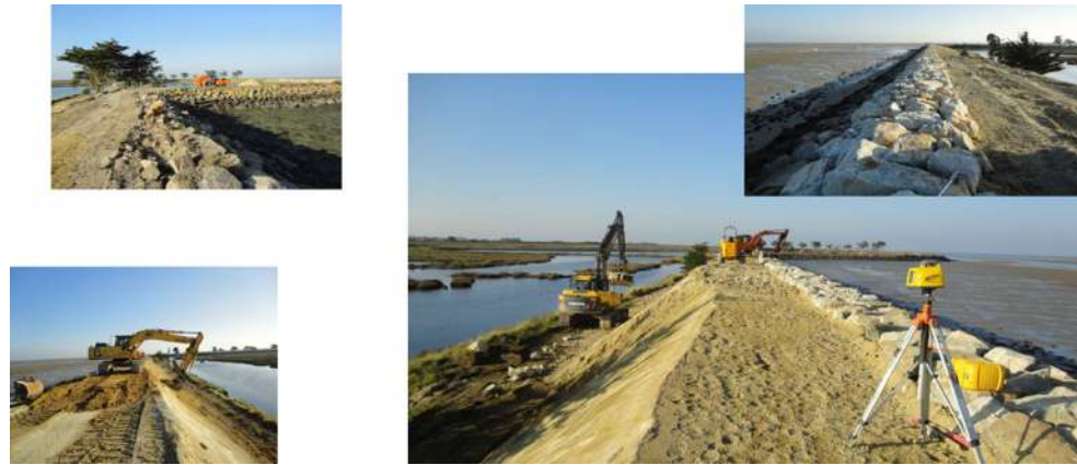
Figure 8.6 : Photos des travaux de rehausse de la digue de Sébastopol en 2014 (CCIN).
