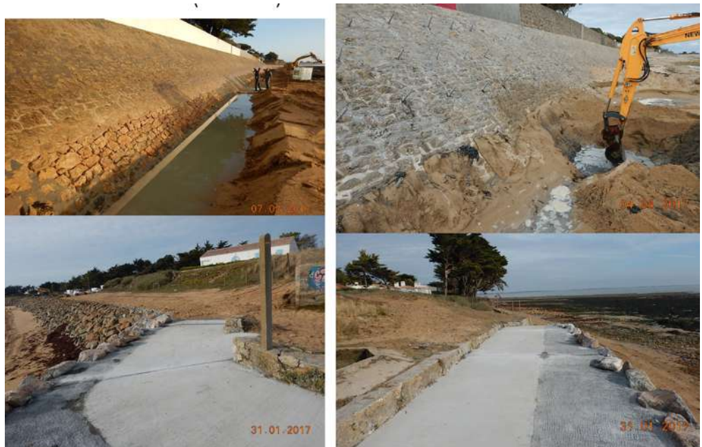
Figure 8.9 : Photos des travaux de consolidation du perré du Mortrit en 2016 (CCIN).
