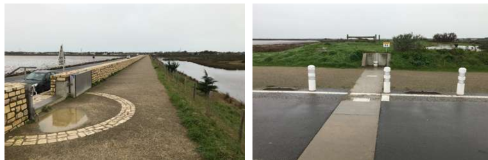
Figure 8.7 : Photos de la digue du Gois rehaussée par un muret et des batardeaux (janvier 2023).
