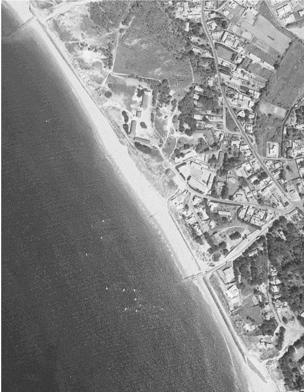
Figure 6.84 : Photographie aérienne de mai 1990 sur le tronçon Saint-Jean/Martinière.
