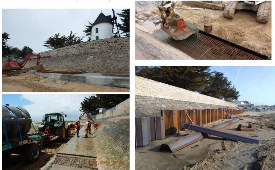
Figure 8.8 : Photos des travaux de consolidation du perré du Both en 2016 (CCIN).
