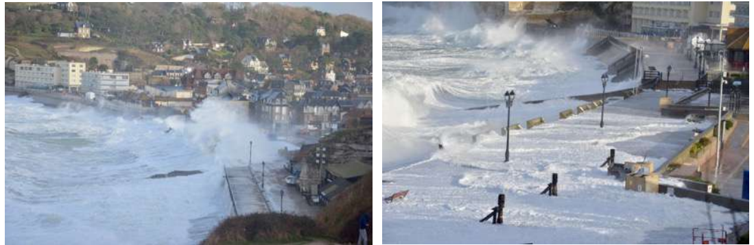
Figure 10.1 : Représentation schématique de la submersion marine par franchissements (BRGM) – Franchissements de la digue d'Etretat en décembre 2019 (CD76).
