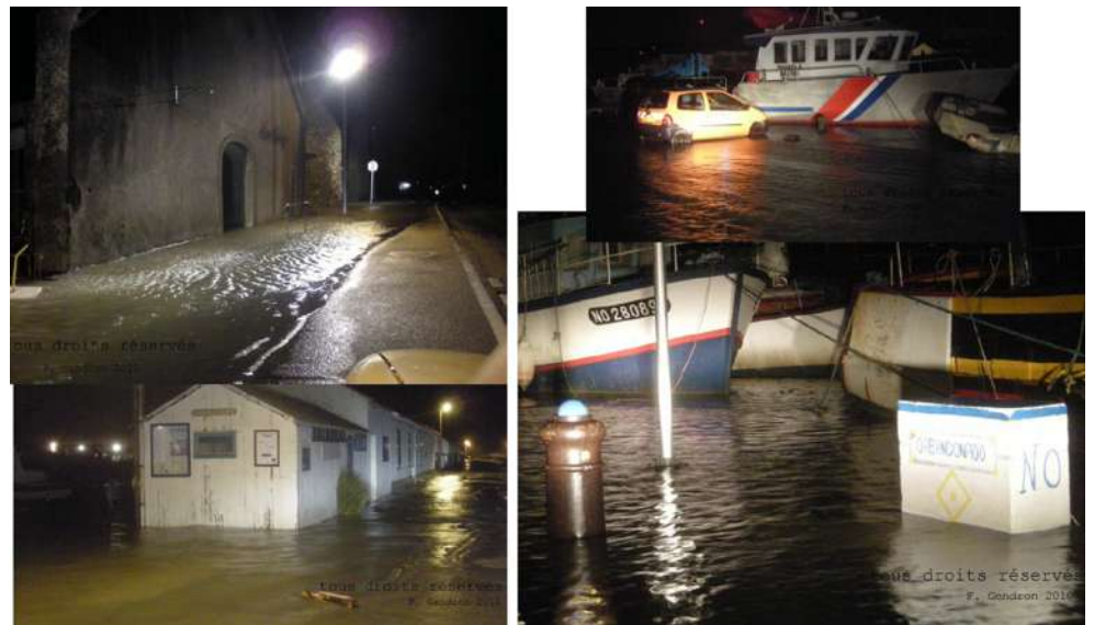
Figure 10.28 : Photographies des submersions au droit du port de Noirmoutier-en-l'Île pendant la tempête Xynthia (F.Gendron).
